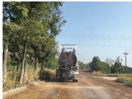
รูปที่ 2-15: การฉีดพรมน้ำบนเส้นทางขนส่งแร่ ช่วงที่ผ่านชุมชน
