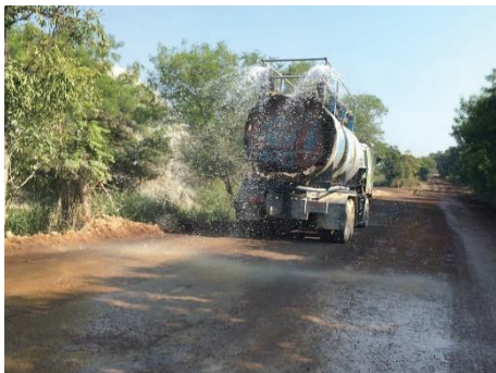
รูปที่ 2-14: การฉีดพรมน้ำบนเส้นทางลำเลียงแร่ ภายในโครงการ
